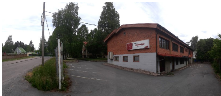
Kuva 4. Suunnittelualueen punatiilinen teollisuusrakennus © Tampereen kaupunki 2019.
